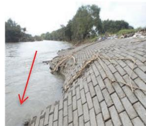
写真2 護岸の被災状況（下流側）
